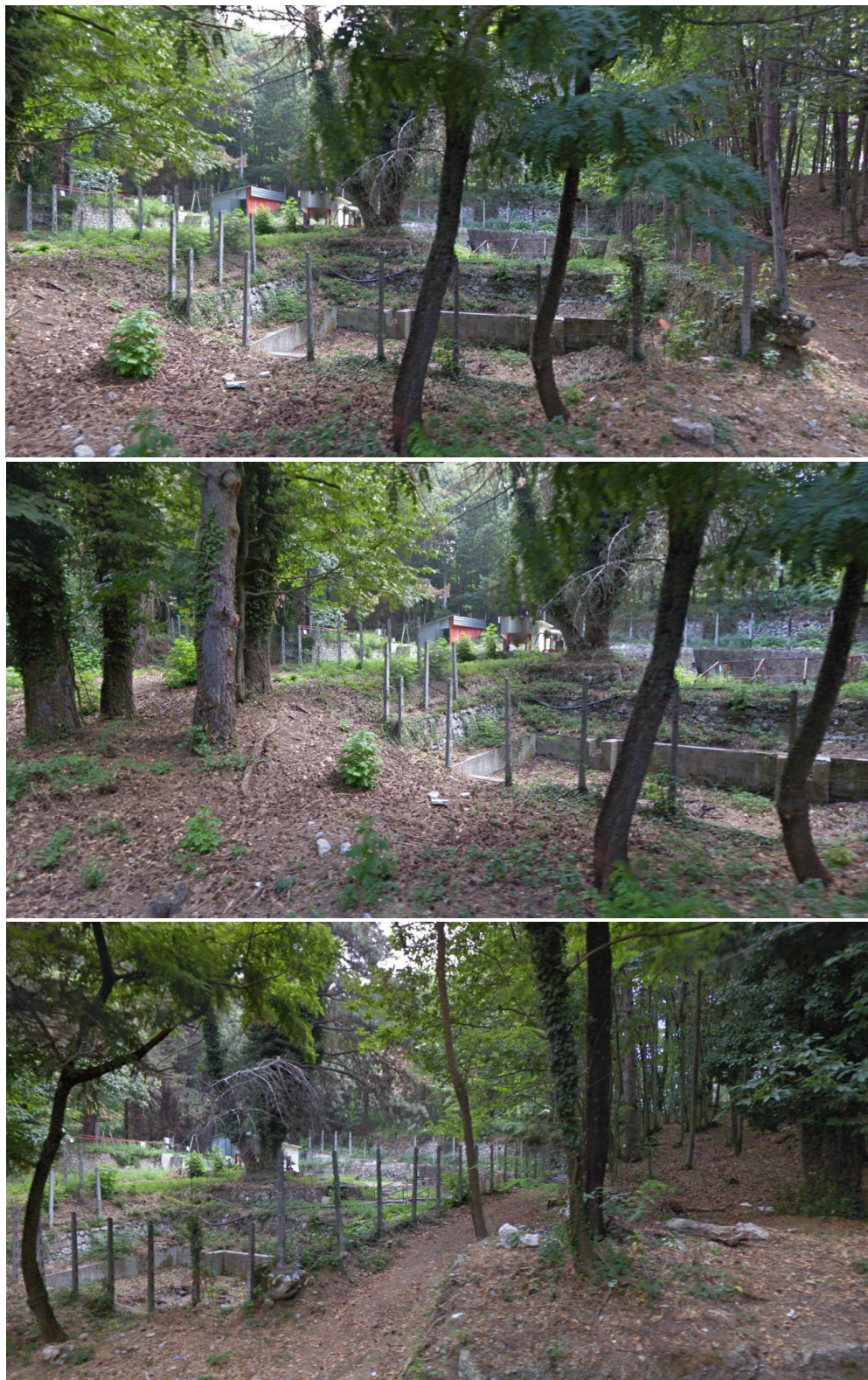
Figg.32-34 – Immagini delle strutture presenti nell'ex impianto "Co.Mo.F."
