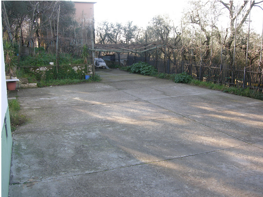
Fig.51 – Piazzale dell'impianto di sollevamento in dismissione a San Salvatore (stato di fatto)
