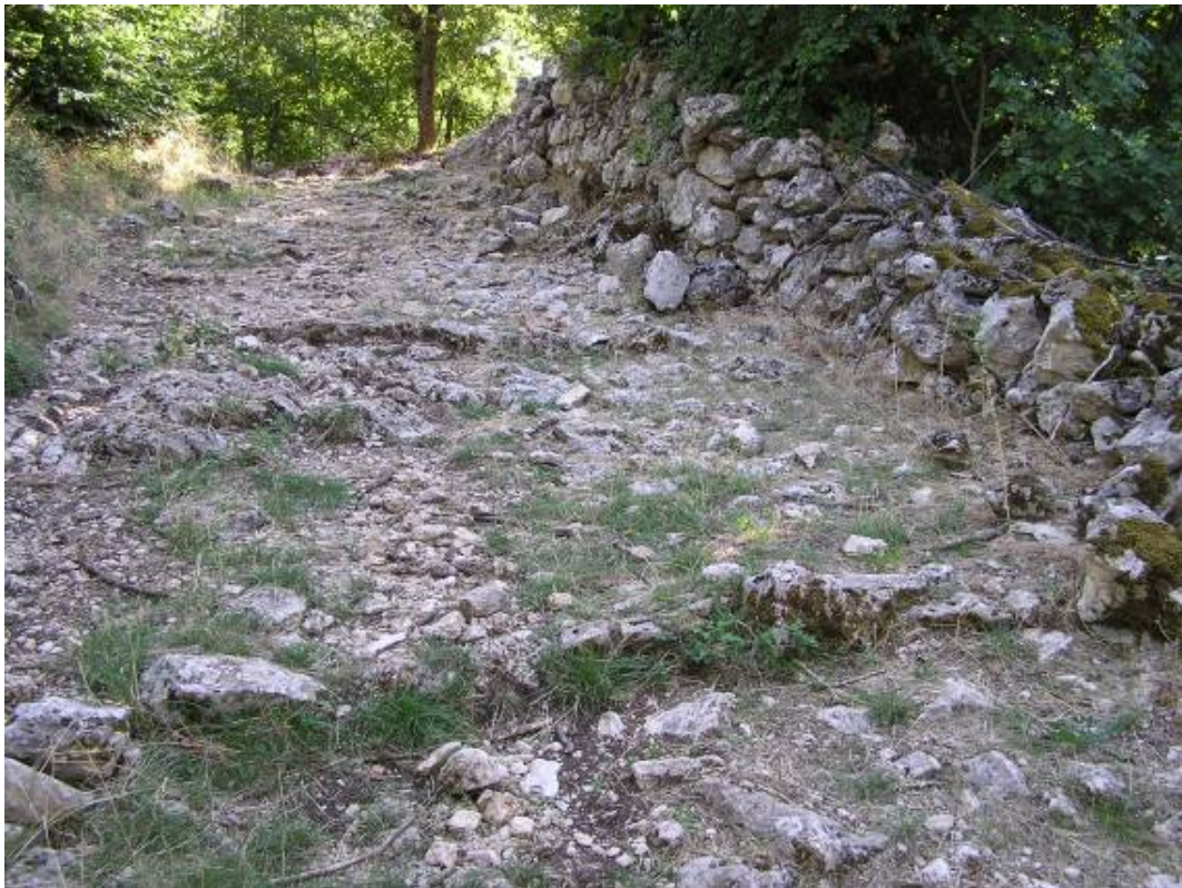
Figg.63-64 – La condotta scorrerà entro un preesistente muretto in pietrame a secco e sarà completamente celata alla vista
