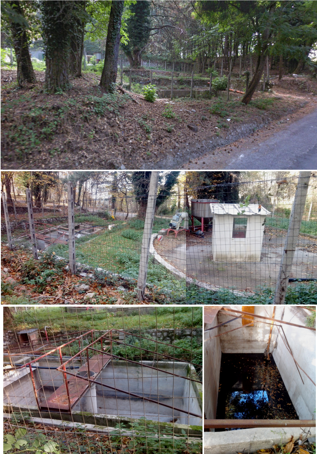
Figg.35-38 – Immagini delle strutture presenti nell'ex impianto "Co.Mo.F."
