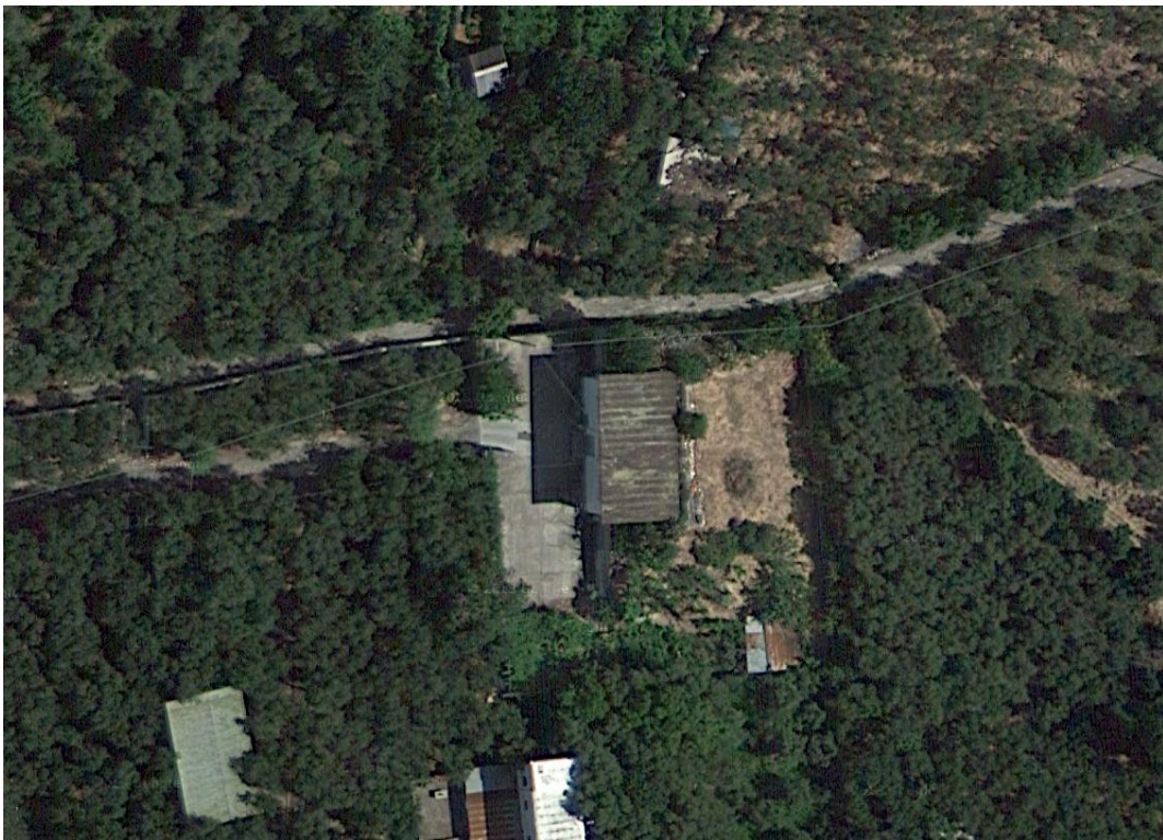
Fig.27 – Foto aerea dell'area dell'impianto di sollevamento in località San Salvatore (Fonte: Google Maps)
