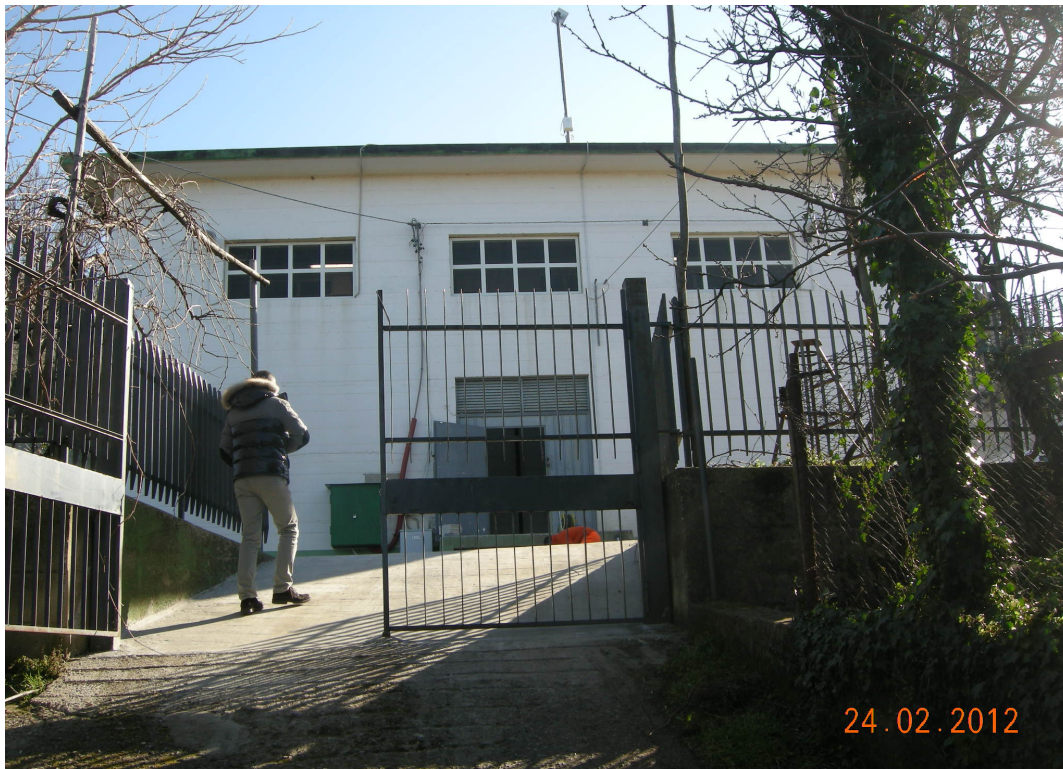
Fig.40 – Rappresentazione fotografica delle strutture attualmente presenti nell'impianto di sollevamento in località San Salvatore
