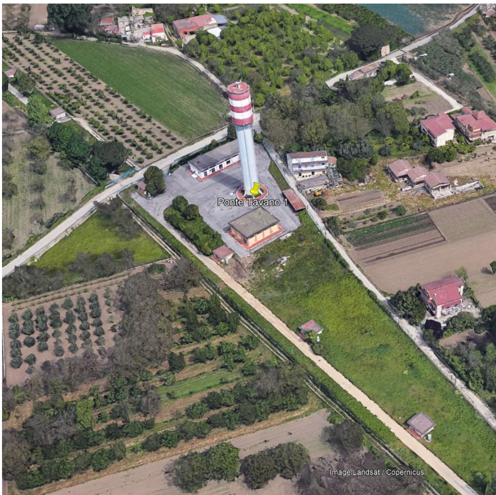
Vista aerea campo pozzi Ponte Tavano I
